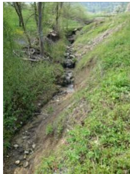
Abbildung 4: Ufersicherung durch Bewuchs (orographisch rechtes Ufer) im Leebächli (Niederdorf)
