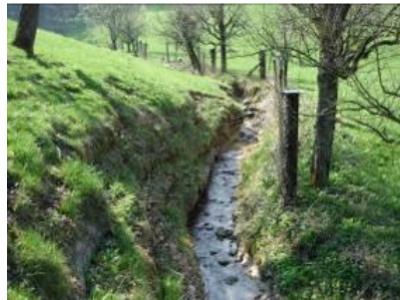
Abbildung 2: Ufersicherung mittels Holzverbau (Wildensteinerbächli (Bubendorf)
